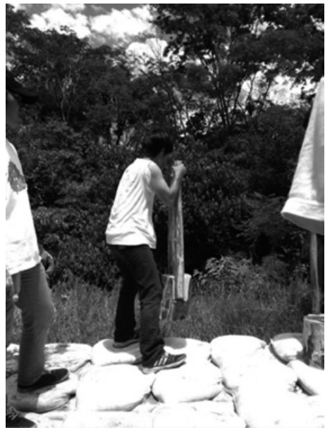
パラグアイで国際協力。土を集めて土嚢袋に入れて敷き詰めて道を直す
