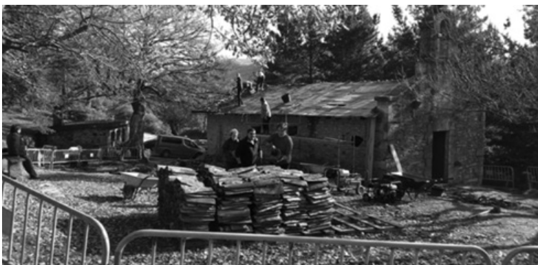
小礼拝堂（エルミタ）の修復作業の風景
